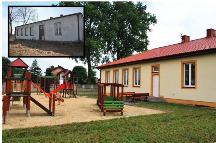
Utworzenie świetlicy środowiskowej poprzez przebudowę budynku wraz z zagospodarowaniem terenu oraz budowa placu zabaw we wsi Tarnowska Wola (Gmina Lubochnia), PROW 2007–2013.
